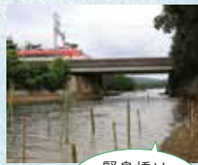
賢島橋は とても短い橋
